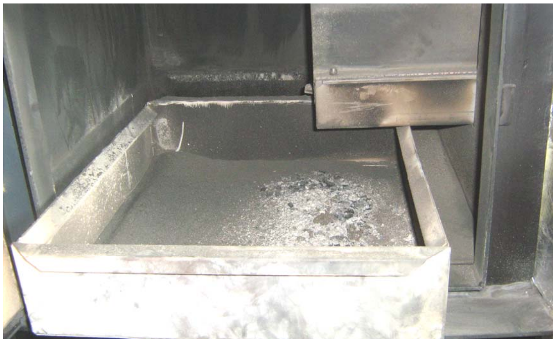
Фигура 2.16. Изваждане на контейнера за пепелта от печната камера на котела;
