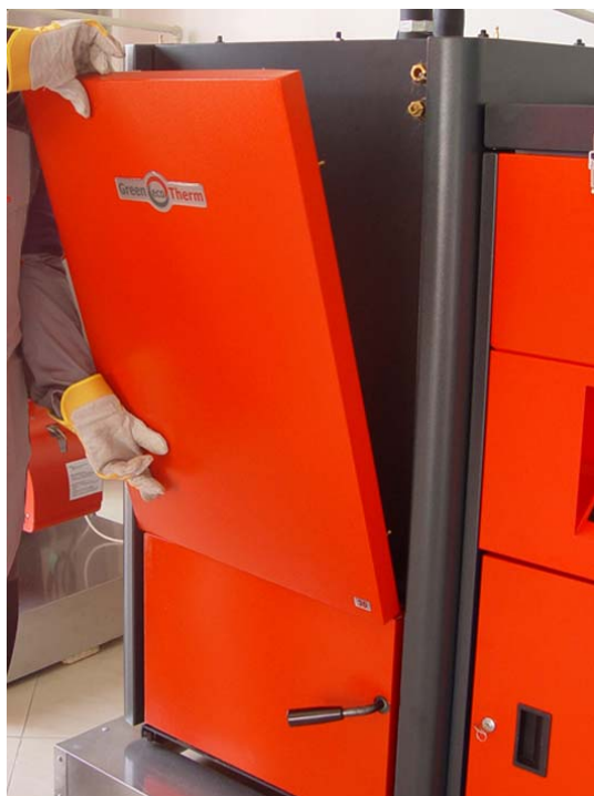
Фигура 2.8. Демонтиране на предния декоративен капак на котела;
