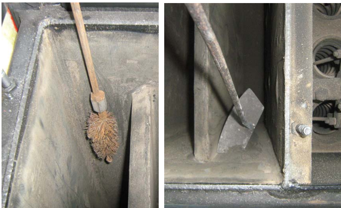
Фигура 2.5. Почистване на пепелния остатък, натрупан по нагревните повърхности на котела;
